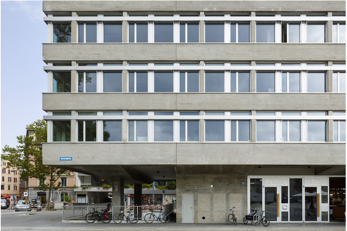
Trotz energetischer Ertüchtigung bewahren die Fassaden des Amteshauses Helvetiaplatz ihren Ausdruck im Stil des «Béton brut» (Bild: Georg Aerni, Zürich).
