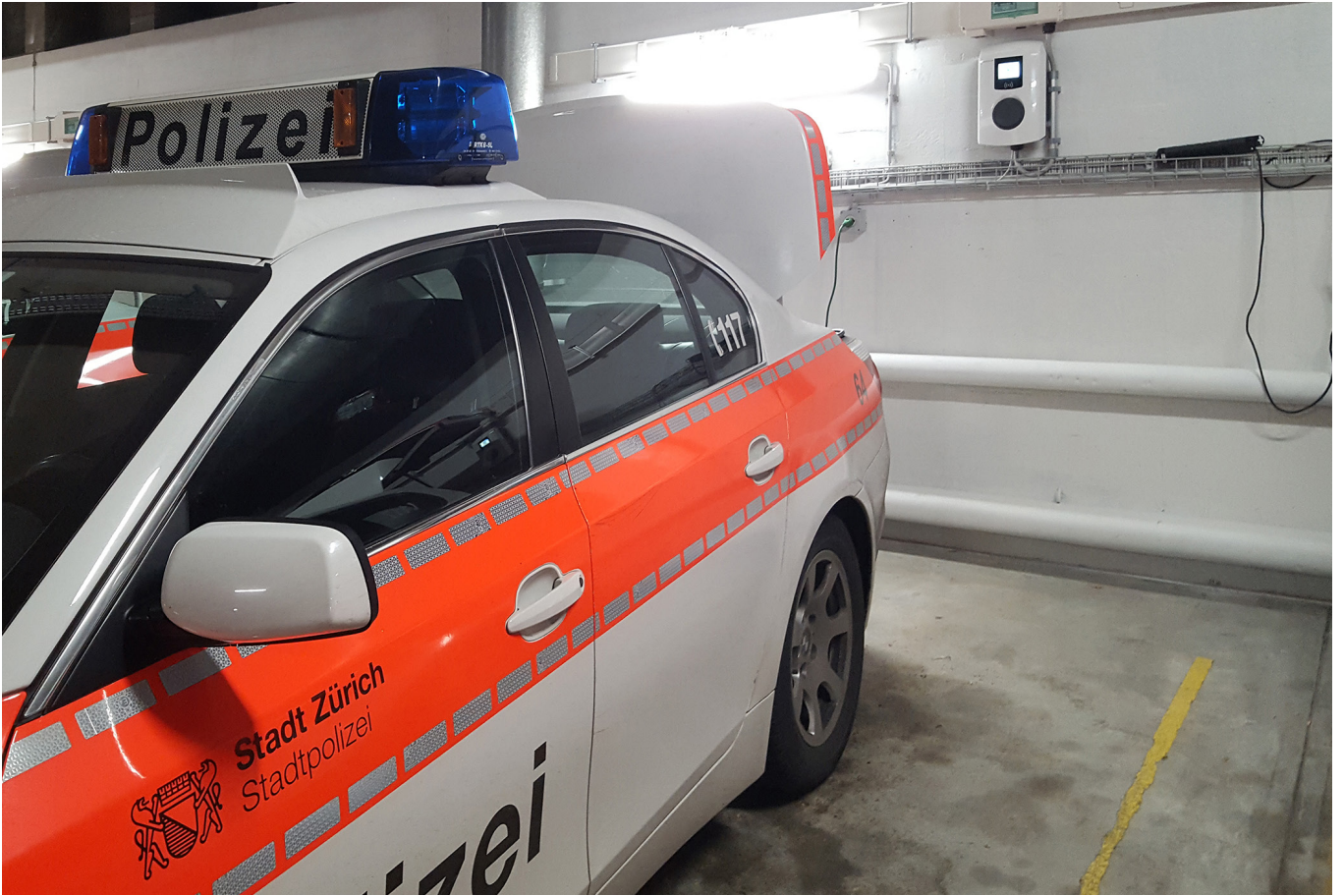
Ladepunkt ab Stromschiene für Elektrofahrzeuge bei der Verkehrspolizei der Stadtpolizei Zürich (Bild: Immo).
