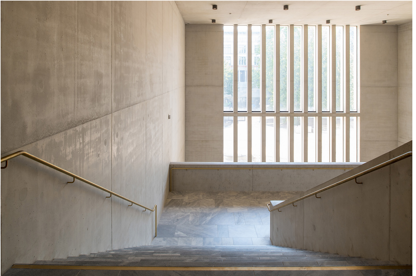
Erweiterung Kunsthaus Zürich: Mit durchdachtem Energiekonzept und über 80 % Recycling-Beton zur 2000-Watt-Gesellschaft (Bild: Juliet Haller, Zürich).
