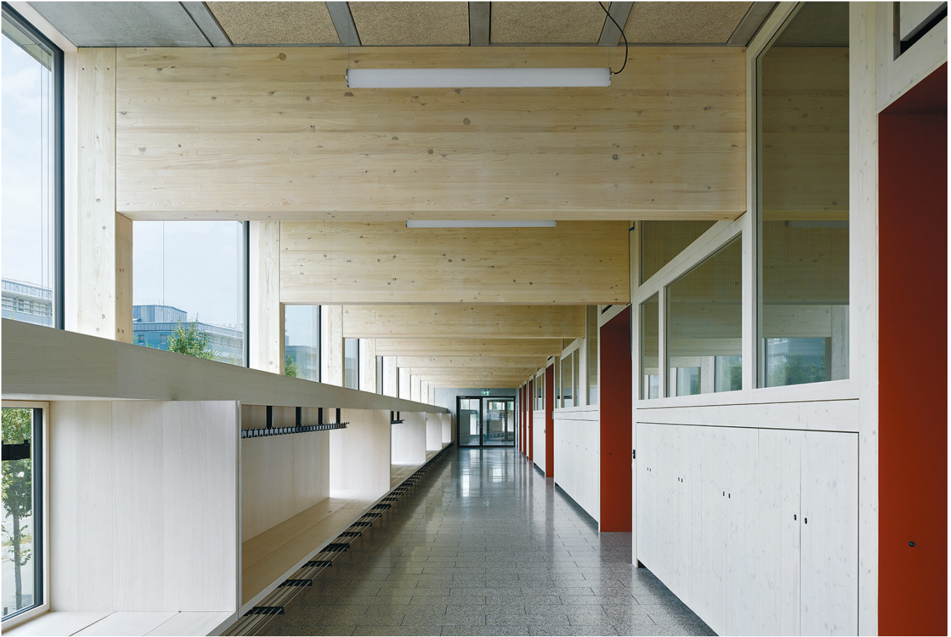
Im Schulhaus Pfingstweid dient der Korridor als Lüftungskanal (Bild: Georg Aerni, Zürich).
