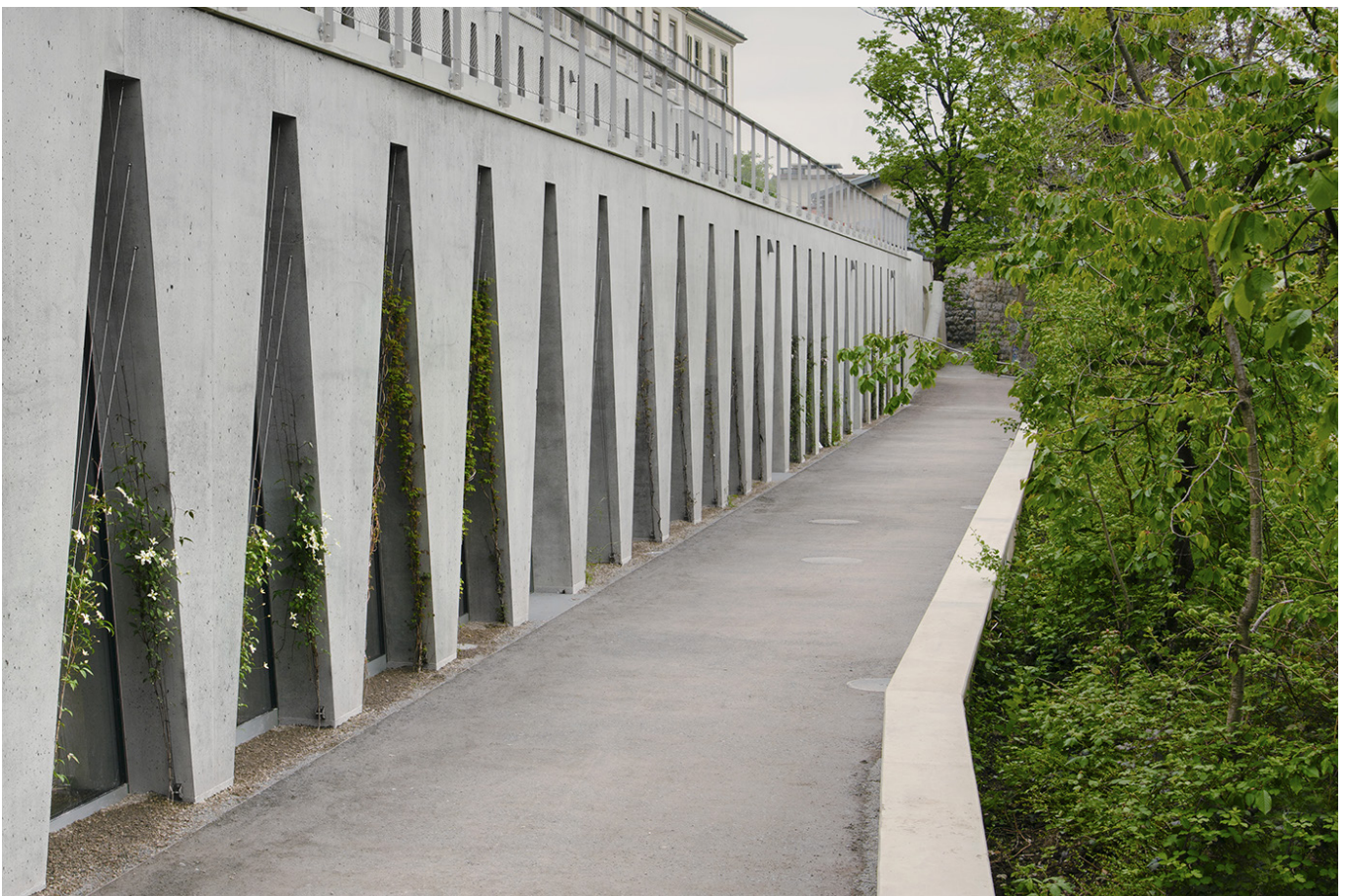
Beim Tanzhaus wird der sommerliche Wärmeschutz von Pflanzen geleistet (Bild: Simon Menges, Berlin).
