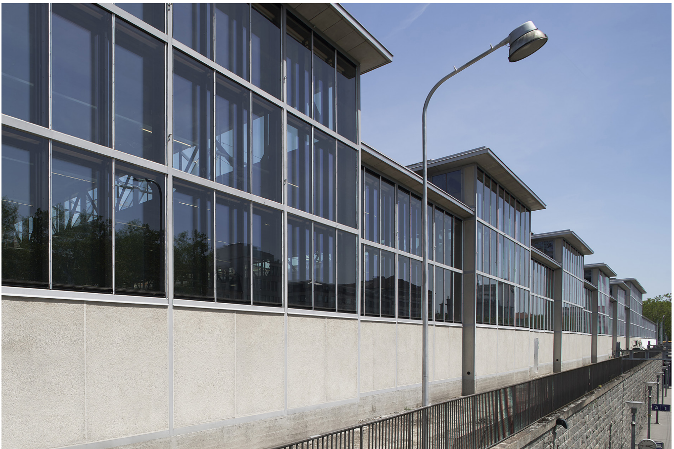
Beim Tramdepot Elisabethenstrasse wurden mit einer zweiten, inneren Fassadenschicht und anderen Massnahmen energetische Schwächen behoben (Bild: Dominic Büttner, Zürich).
