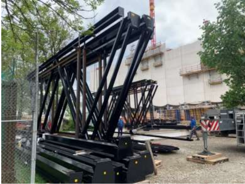
Vorbereitungen Stahlträger für Stahldachmontage
