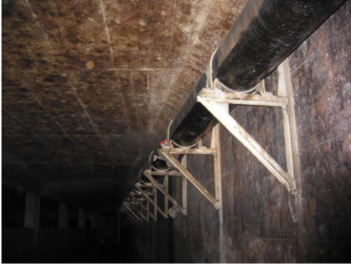
Bild 2: Abschnitt 6, in begehbaren Kanal eingehängter Döltschibach (HPE, Ø 315 mm), bei KE 25105.
