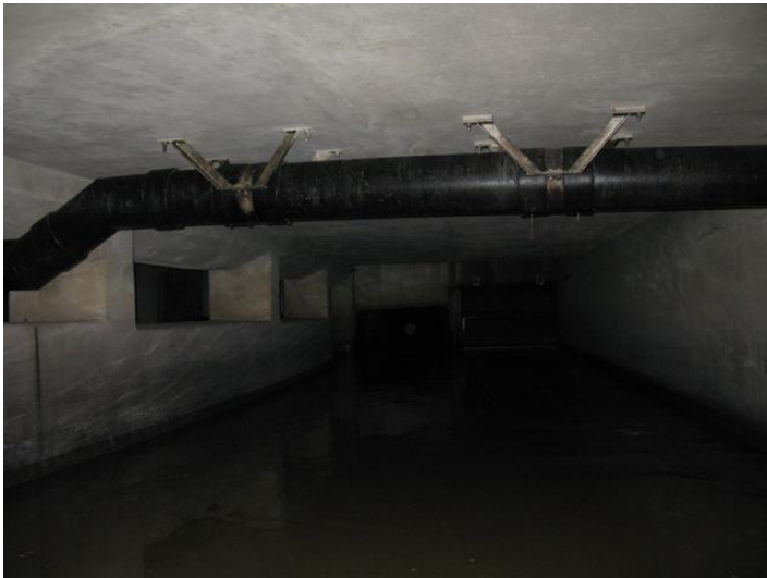
Bild 1: Abschnitt 4; in begehbaren Kanal eingehängter Döltschibach (HPE, Ø 315 mm), bei KE 28897
