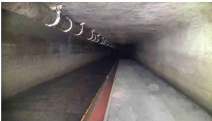
Bild 3: Abschnitt 8, in begehbaren Kanal eingehängter Döltschibach
