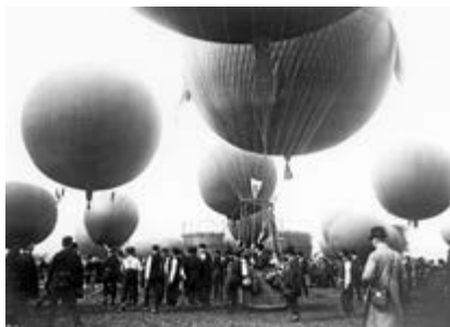
Gaswerk der Stadt Zürich Schlieren, Kohlestrasse 12 BAZ 1909
