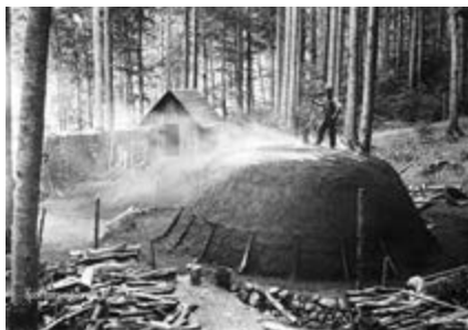
Holzarbeiten im Sihlwald Sihlwald, Langnau am Albis Max Hotz um 1893
