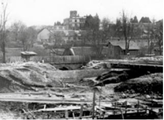
Bau des Bahntunnels und der Sihlumléitung um 1919. Foto: Baugeschichtliches Archiv der Stadt Zürich.
