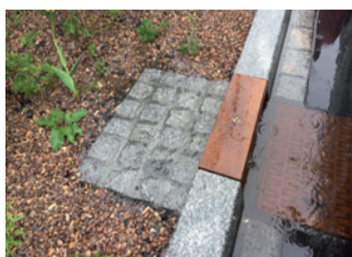
Das Wasser fliesst durch den offenen Schieber ins Bodensubstrat. Foto: Andrea Saluz
