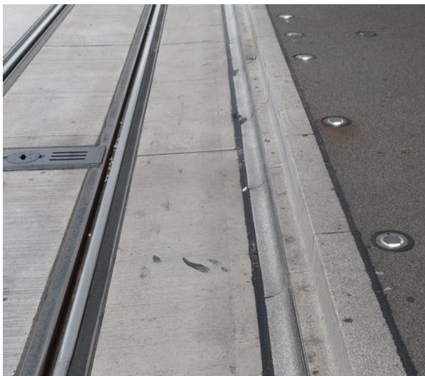
Haltekante Hardbrücke (Tram / Bus)
