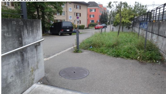
Defizit ④: Zugang zum Bahnhof direkt von Fahrbahn ist gefährlich (Sichtverhältnisse).
