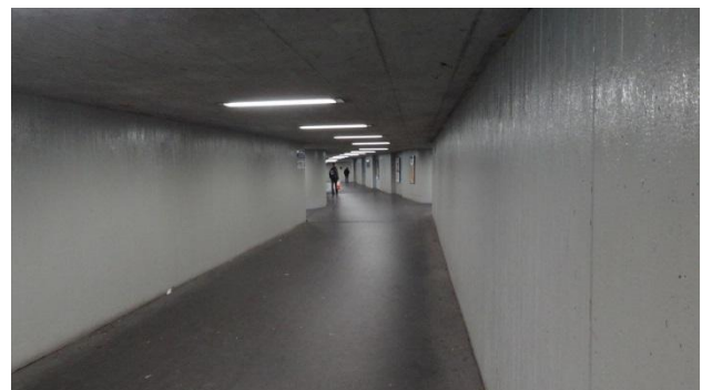
Defizit ❷: Orientierung/ subjektive Sicherheit in Unterführung schlecht
