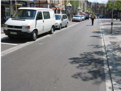
Aufenthaltsstrasse mit Seitenbändern Edisonstrasse - Randabschluss mit minimalem Anschlag, einseitig Elemente und Längsparkierung
