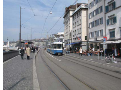
Aufenthaltsstrasse mit Seitenbändern Limmatquai - Tram in Fahrverbotszone, beidseitige Randabschlüsse mit minimalem Anschlag und Elementen
