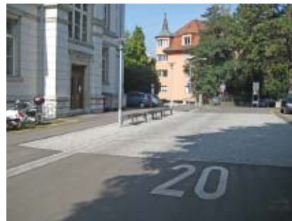
Aufenthaltsstrasse mit Seitenbändern Huttenstrasse - Seitlich längsverlaufende Friesstreifen (ein- und dreireihig), Platzgestaltung mit Granitpflasterung à Niveau
