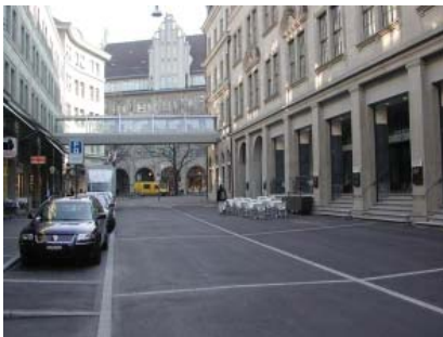
Aufenthaltsstrasse mit Seitenbändern Bärengasse - Randabschluss mit minimalem Anschlag und Parkierung sowie Randabschluss ohne Absatz, Friesstreifen quer
