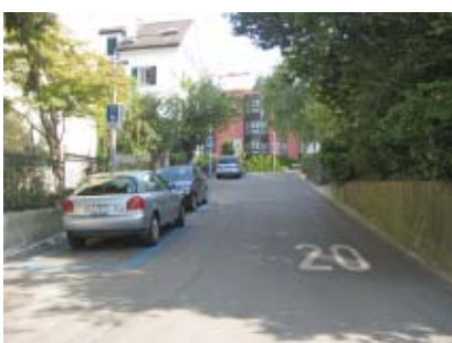
Schmale Aufenthaltsstrasse Huttensteig - Mischverkehrsfläche à Niveau ohne Kennzeichnung der Fahrbahn
