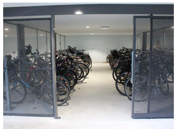
Abschliessbare Anlage: Einzäunung in einer Tiefgarage
