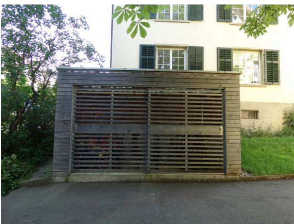
Abschliessbare Anlage: Gedeckte Einzäunung
