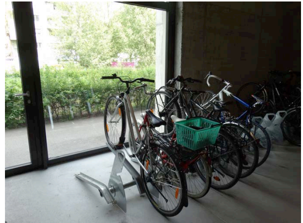
Ebenerdiger Veloraum mit direktem Zugang von aussen.
