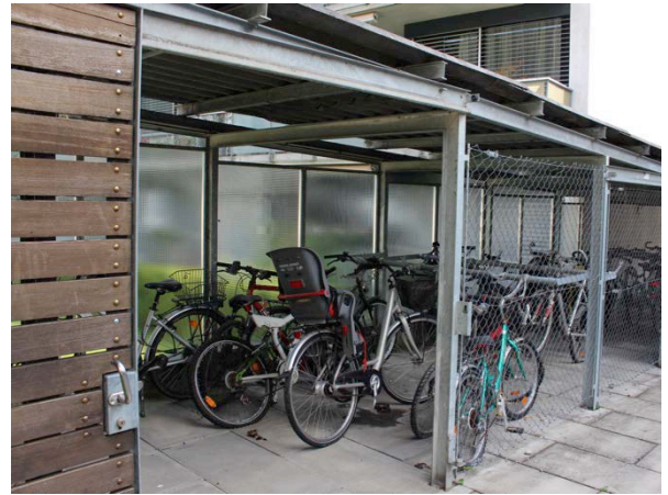
Abschliessbarer Velounterstand im Aussenraum der Siedlung Unterer Schweighof.
