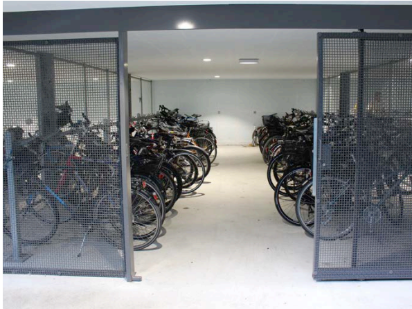
Der Veloraum der Siedlung Brombeeriweg ist über eine via Rampe und Treppe (zu den Hauseingängen) erschlossen.
