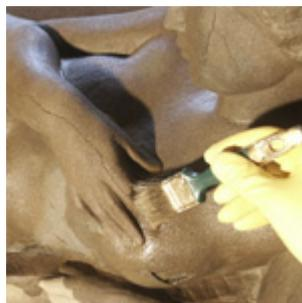
Festigung (nach längerer Austrocknungsphase)
