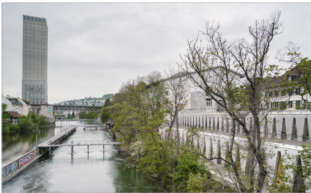
Bild 2: Durch die abgetreppte Fassade wird das Volumen geschickt in die Hanglage integriert. Die Dachflächen sind öffentlich begehbar.
