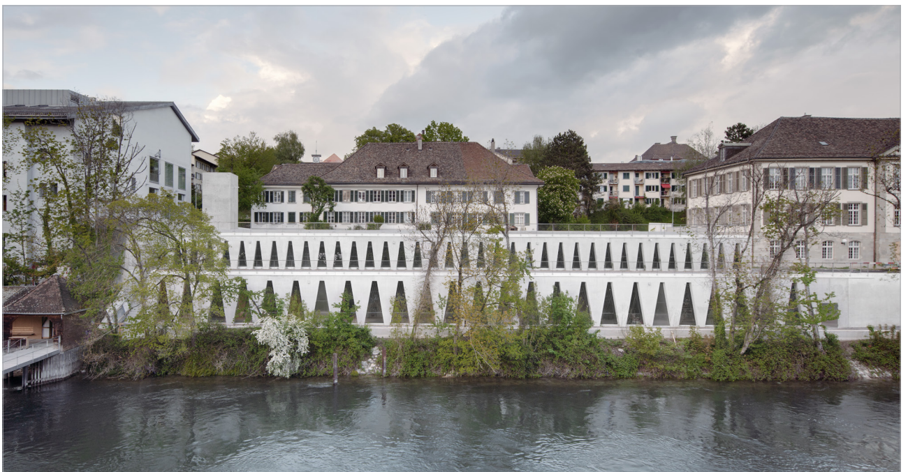
Blick auf den Ersatzneubau Tanzhaus. Foto: Simon Menges, Berlin
