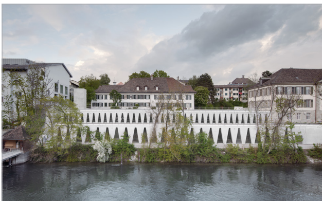
Bild 1: Blick auf den Ersatzneubau Tanzhaus.
