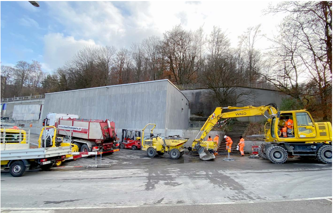
An das bestehende Reservoir angebautes Pumpwerk Strickhof
