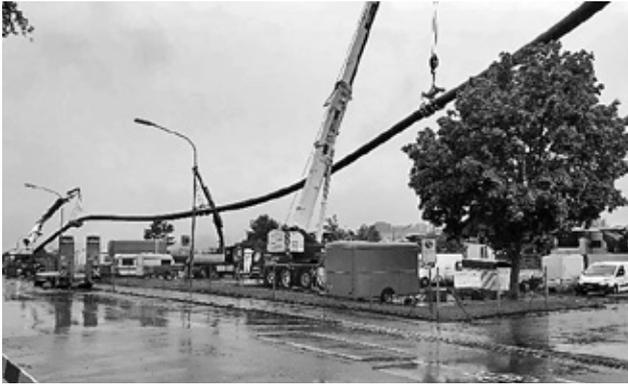
Vier 160m lange Anergieleitungen wurden im Spülbohrverfahren unter der Autobahn A1 durchgestossen. (Bild: ewz)
