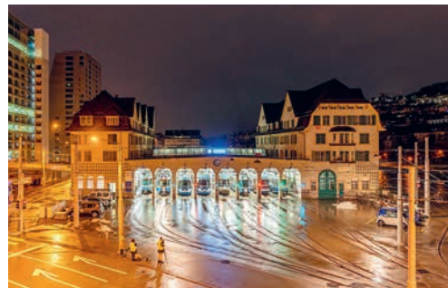
Das Depot Hard stellte Ende Januar den Betrieb ein, weil es umfassend saniert und erweitert wird. Die Neueröffnung ist für Ende 2025 geplant. (Bild: VBZ)
