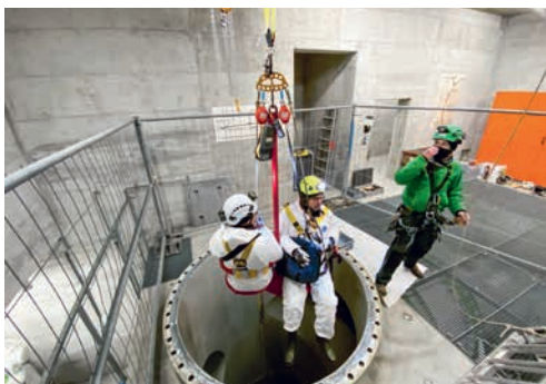
Schachtkopf Reservoir Strickhof: Einstieg der Spezialisten in den Steigschacht. (Bild: WVZ)
