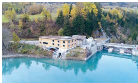
Die neue Kraftwerkszentrale Adont beim Wehr Burvagn. Das Kraftwerk wird jährlich 10,2 Gigawattstunden (GWh) Naturstrom produzieren. Dies entspricht dem jährlichen Strombedarf von rund 4300 Stadtzürcher Haushalten. (Bild: ewz)
