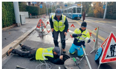
Limmatalstrasse: Einbau der Multiparametersonde im Mess-Schacht (Bild: WVZ)
