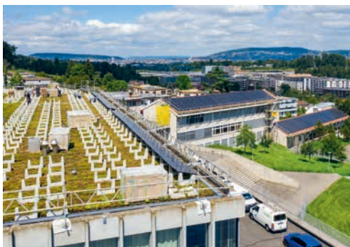
Die PV-Anlage auf dem Schulhaus Fallletsche aus dem Solar-Beteiligungsmodell ewz.solarzüri wurde im Sommer 2021 erstellt. Sie umfasst rund 1100 m 2 Fläche, verfügt über eine Leistung von 148 kWp und soll künftig 88 000 kWh Sonnenstrom pro Jahr produzieren. (Bild: 20min/Michael Scherrer)
