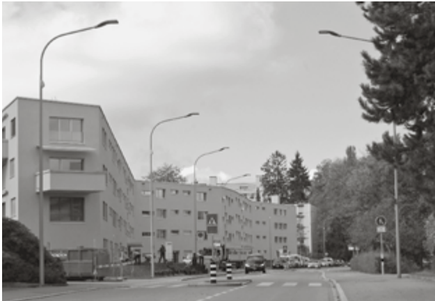
LED-Strassenbeleuchtung an der Furttalstrasse. (Bild: ewz)
