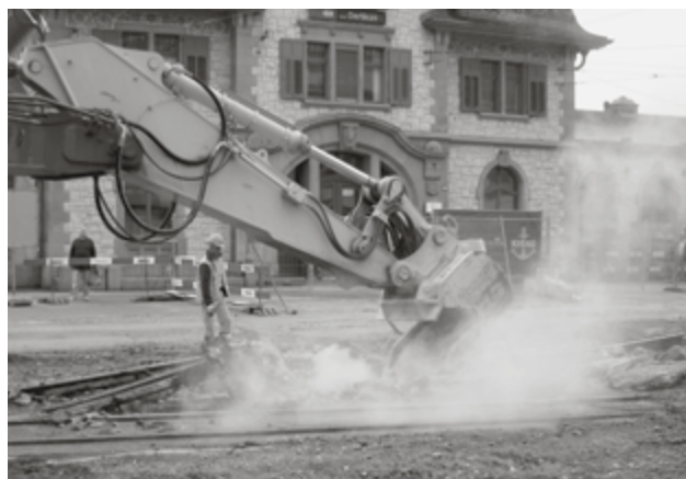
Gleiserneuerung am Bahnhof Oerlikon. (Bild: VBZ)
