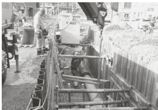
Leitungsbau. (Bild: Wasserversorgung)
