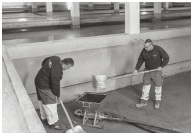
Reinigung des Langsamfilters im Seewasserwerk Lengg. (Bild: Wasserversorgung)
