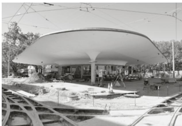
Grossbaustelle Bellevue erfolgreich gemeistert. (Bild: VBZ)
