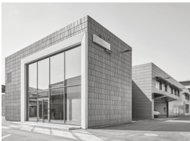
Das neue ewz-Unterwerk Oerlikon. (Bild: Roger Frei, Zürich)
