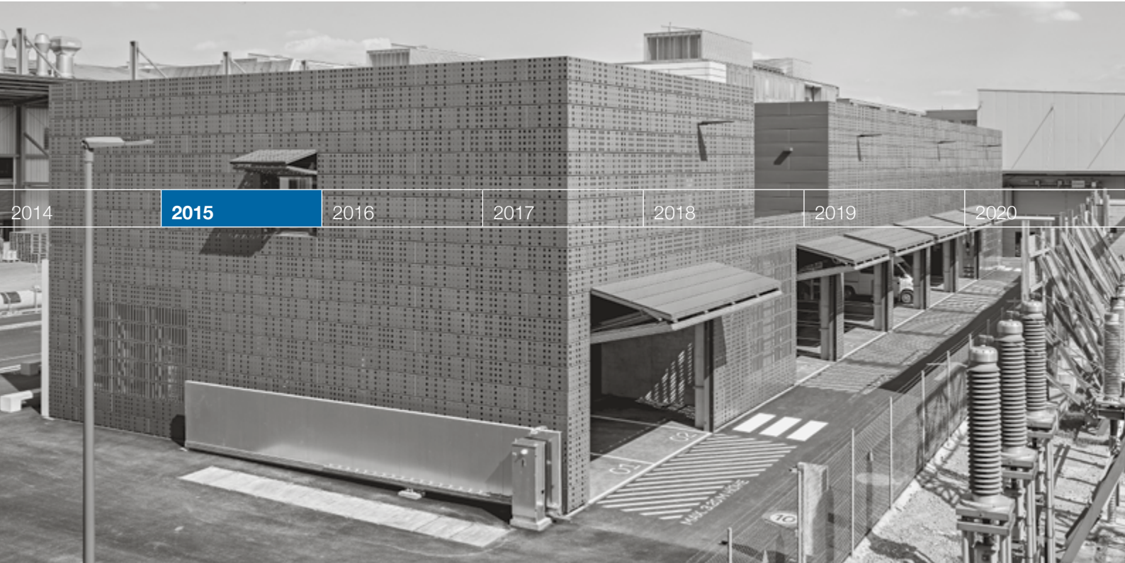
Das neue ewz-Unterwerk Oerlikon. (Bild: Roger Frei, Zürich)
