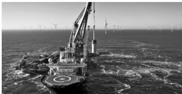
Das erste Stahlfundament für den Trianel Windpark Borkum II wurde Ende Juni erfolgreich im Meeresboden verankert. (Bild: TWB II/ewz)
