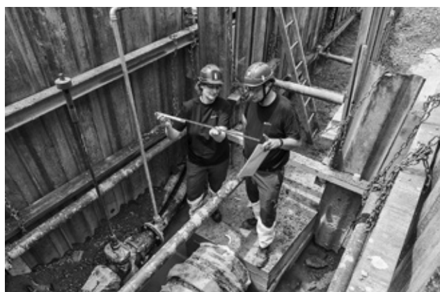
Vermessung der neuen Rohrleitungen. (Bild: WVZ)
