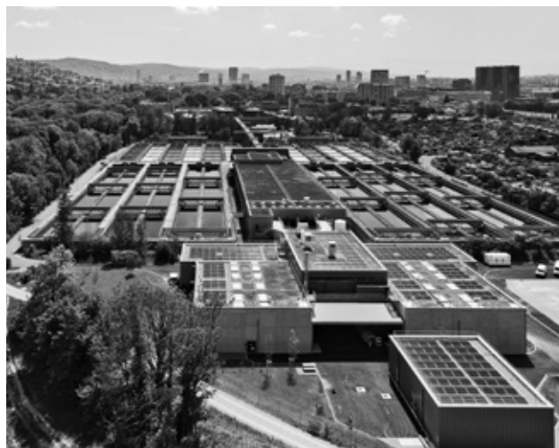
In Zürich-Altstetten und Teilen von Höngg sollen Liegenschaften mit dem gereinigten Abwasser aus dem Klärwerk Werdhölzli als Energiequelle klimafreundlich geheizt und gekühlt werden. (Bild: ewz)
