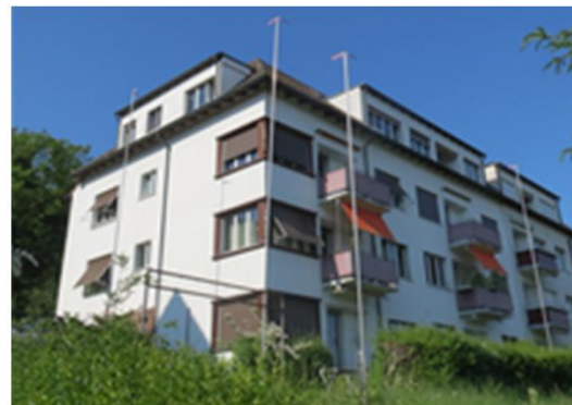
Foto Süd- und Westfassade mit Baugespann
