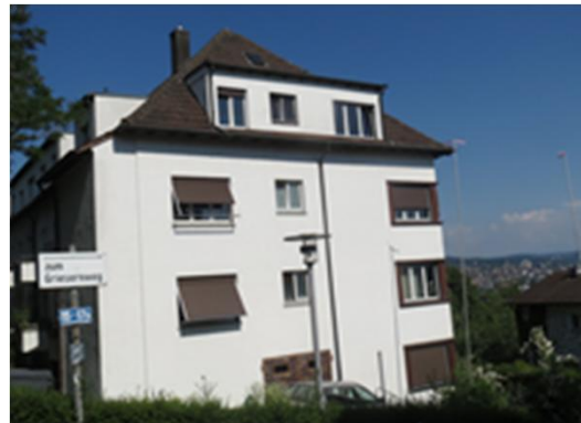
Foto Westfassade Bestand ohne Anbau
