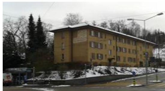
Gebäude inkl. Kiosk
