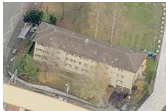
Luftbild West (Solardachflächen)
