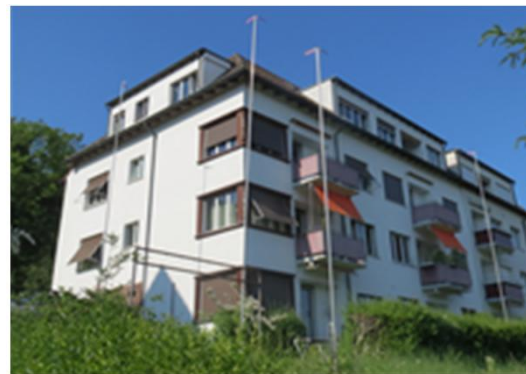
Foto Süd- und Westfassade mit Baugespann
