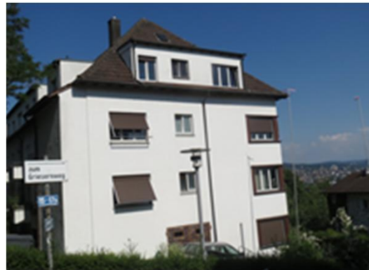
Foto Westfassade Bestand ohne Anbau
