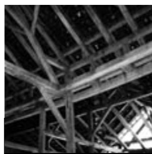
Ständergerüst und Dachkonstruktion mit mannigfaltigen Holzverbindungen in einer Scheune des 19. Jh. in Zürich-Fluntern.
