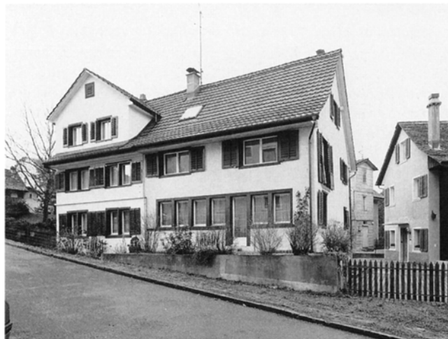
Forchstrasse 297–305. Das alte Doppelwohnhaus Nr. 303 (rechts) und Nr. 305 (links). Am rechten Bildrand Forchstrasse 301. Dazwischen knapp sichtbar der hölzerne Treppenhaus- und Abtrittanbau von Forchstrasse 297. (Foto BAZ, 1993)
