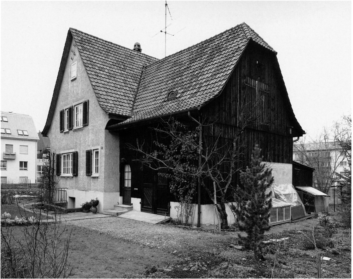
Tramstrasse 85. Wie auch beim Haus Tramstrasse 73 handelt es sich um einen Vertreter des Haustyps A, mit rechtsseitig angebauter Stallscheune. (Foto N. Brändli, 1991, BAZ)
