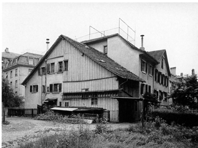
Culmannstrasse 27 und 29, von Nordwesten. Ein Teil der ehemaligen Scheunenerweiterung ist noch immer verbrettert. (Foto BAZ, 1966)
