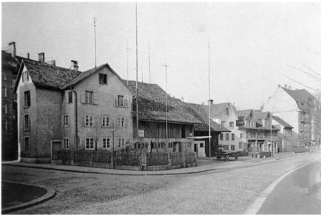
Blick von Süden in die Zweierstrasse. Im mittleren Bildteil die heute noch bestehenden Nrn. 170 und 174–178, samt dem oberen Nachbargebäude gleichen Typs kurz vor dessen Abtragung im Februar 1938. (Foto Stadtarchiv, BAZ)
