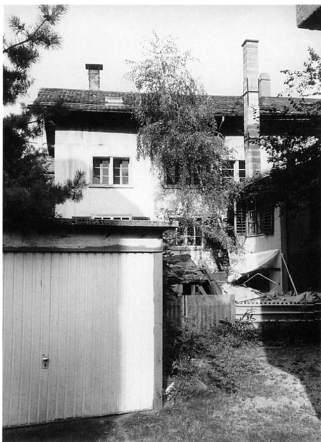
Zweierstrasse 178, der rückseitig angebaute, dreigeschossige Mietskasernenbau aus dem Jahr 1860. (Foto BAZ, 1999)
