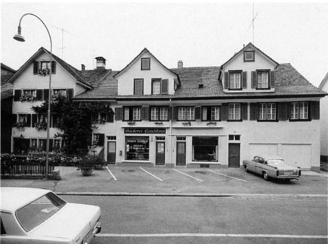
Zweierstrasse 174 (rechts), mit einer Fensterreihe mit unterschiedlichen Fenstertypen und den beiden Dachaufbauten vermutlich von 1823 (links) und 1833 (rechts). Zweierstrasse 176 (links) mit der Quergiebel-Aufstockung aus der Mitte des 19. Jh. (Foto BAZ, 1968)
