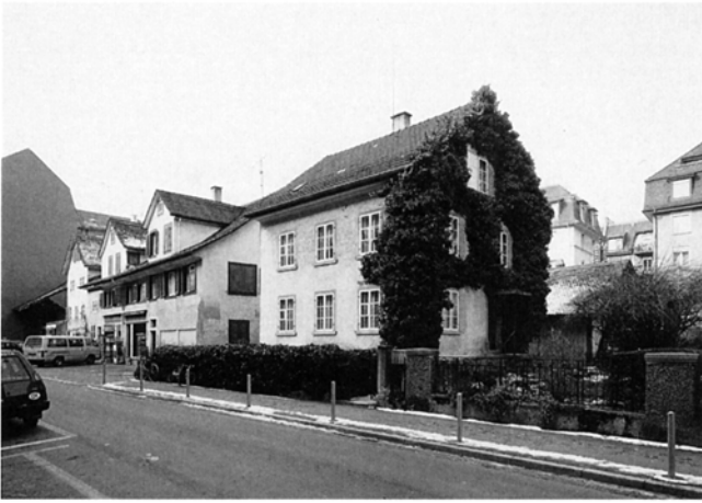
Zweierstrasse 170 und 174–178 aus der Richtung der Schmiede Wiedikon. Links die Brandmauer von 1938. (Foto BAZ, 1991)
