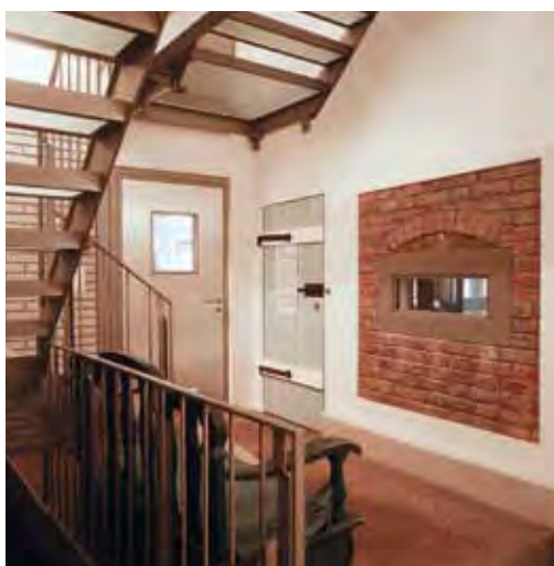
Die neue Erschliessung im ehemaligen Tenn, ein neues Fenster in der ehemaligen Futterluke.
