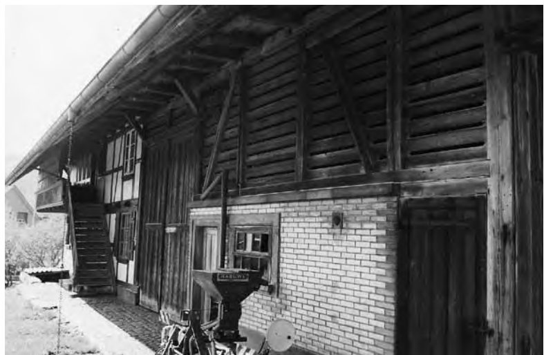
Stall aus Backsteinmauerwerk, darüber die durchlässige Holzkonstruktion.
