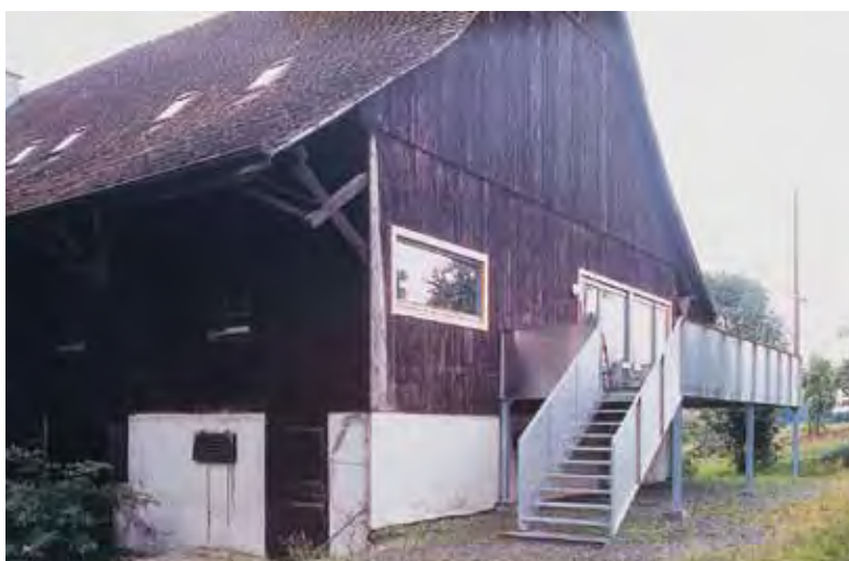
Die neuen Fenster sind flächenbündig in der Verbretterung eingelassen.
