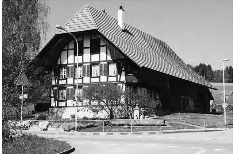
Ein Berner Bauernhaus mit Wohnteil, Stallscheune und Wagenschopfanbau.
