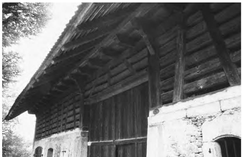
Eine luft- (und licht-)durchlässige Holzkonstruktion über dem gemauerten Erdgeschoss.
