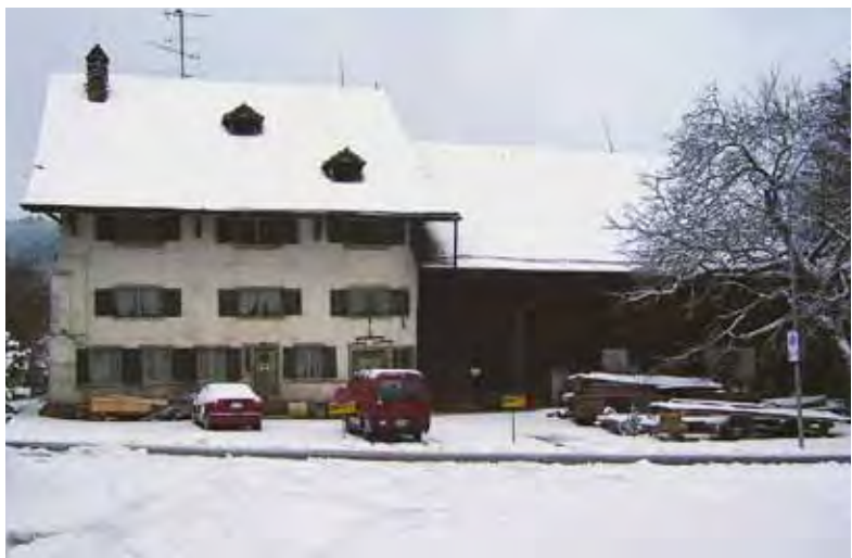
Stettbachstrasse 51 (erbaut 1556/57). Beim Kehlhof Schwamendingen wurde der Wohnteil im 18. Jh. um ein Geschoss erhöht. Zwei Ställe mit verputztem Backsteinmauerwerk im mehrmals verlängerten Scheunenteil.
