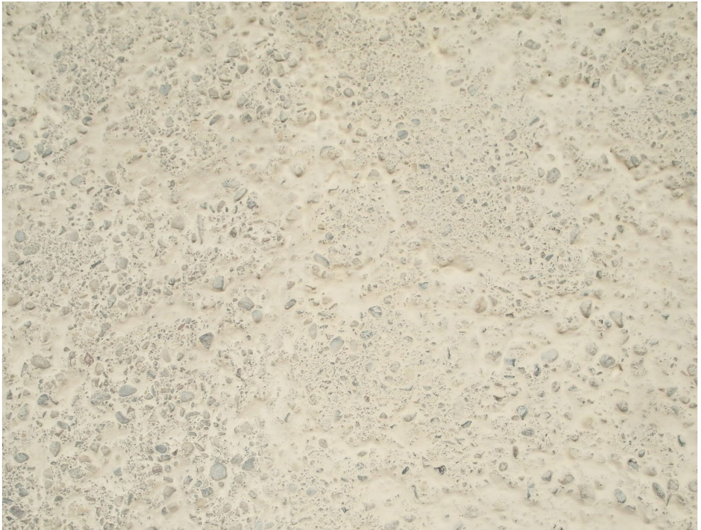
Gasometerstrasse: Musterfläche lasierend aufgebrachtener Organosilikatfarbe über ausgebesserten Kalk-Zementputz mit nicht entfernbarem organischen Tiefengrund.
