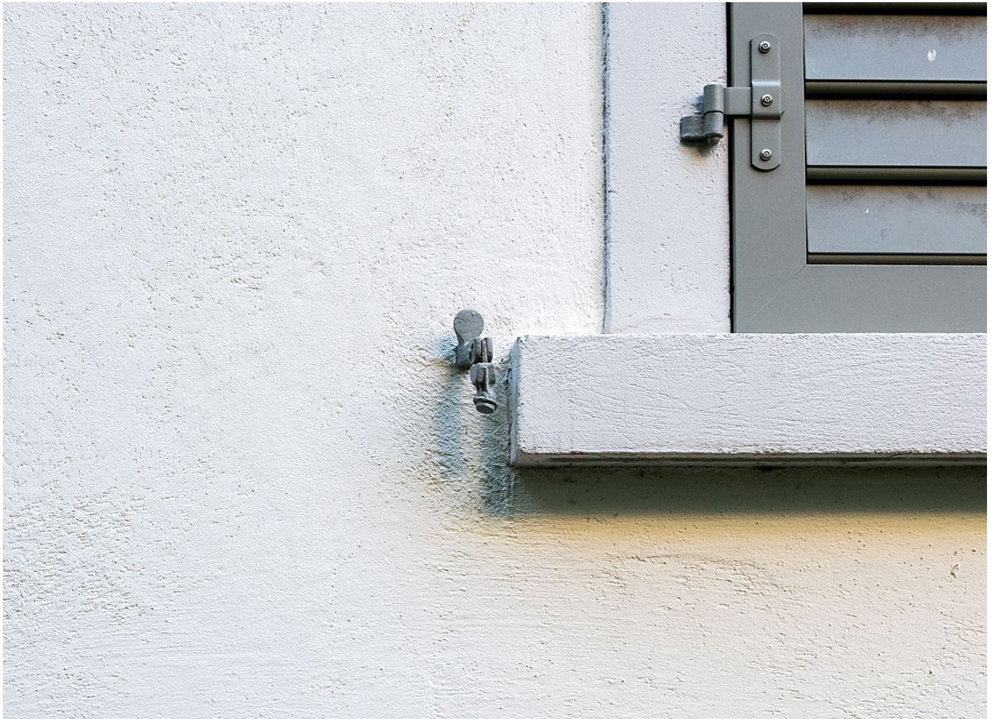
Lägerstrasse: Hoffassade mit Kalkanstrich auf neuem Kalkputz
