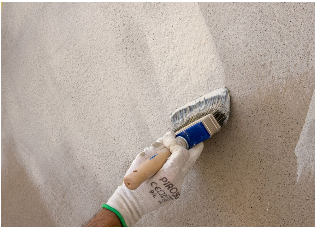
Auftrag Kalkfarbe mit Bürste im Kreuzschlag
