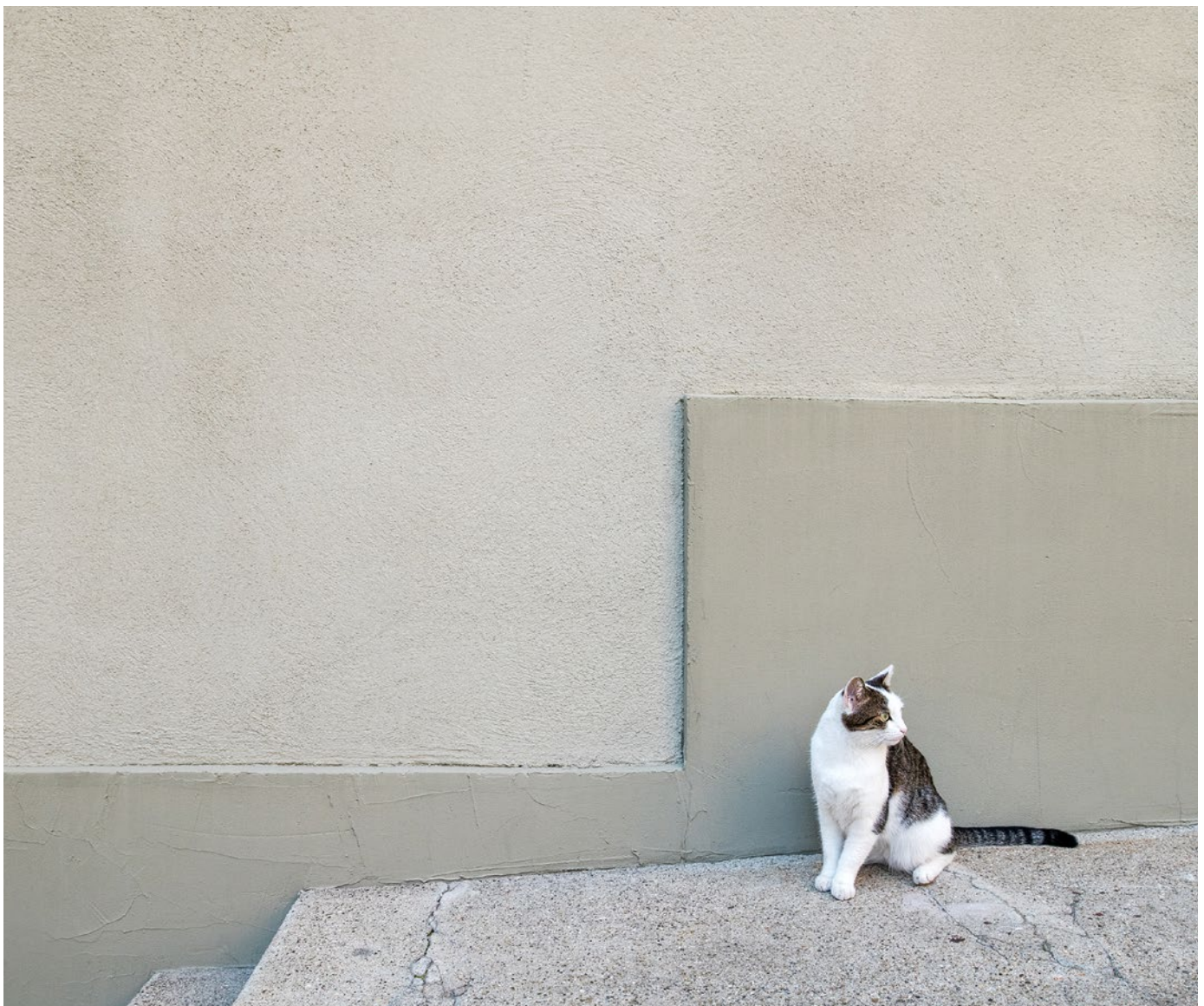
Burgstrasse: Dünn aufgebrachte Aussendämmung mit Mineralwolle, Dickschicht-Kalkputz, Kalkanstrich
