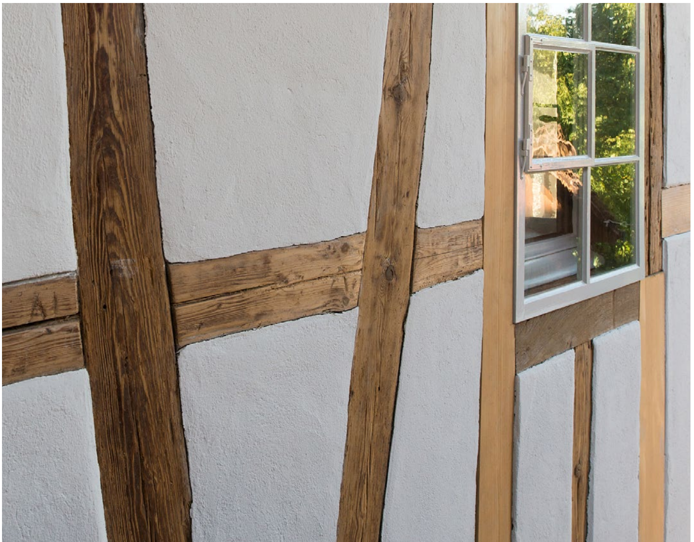
Burenweg, Kalk-Kaseinfarbe auf Putzflächen in den Ausfachungen
