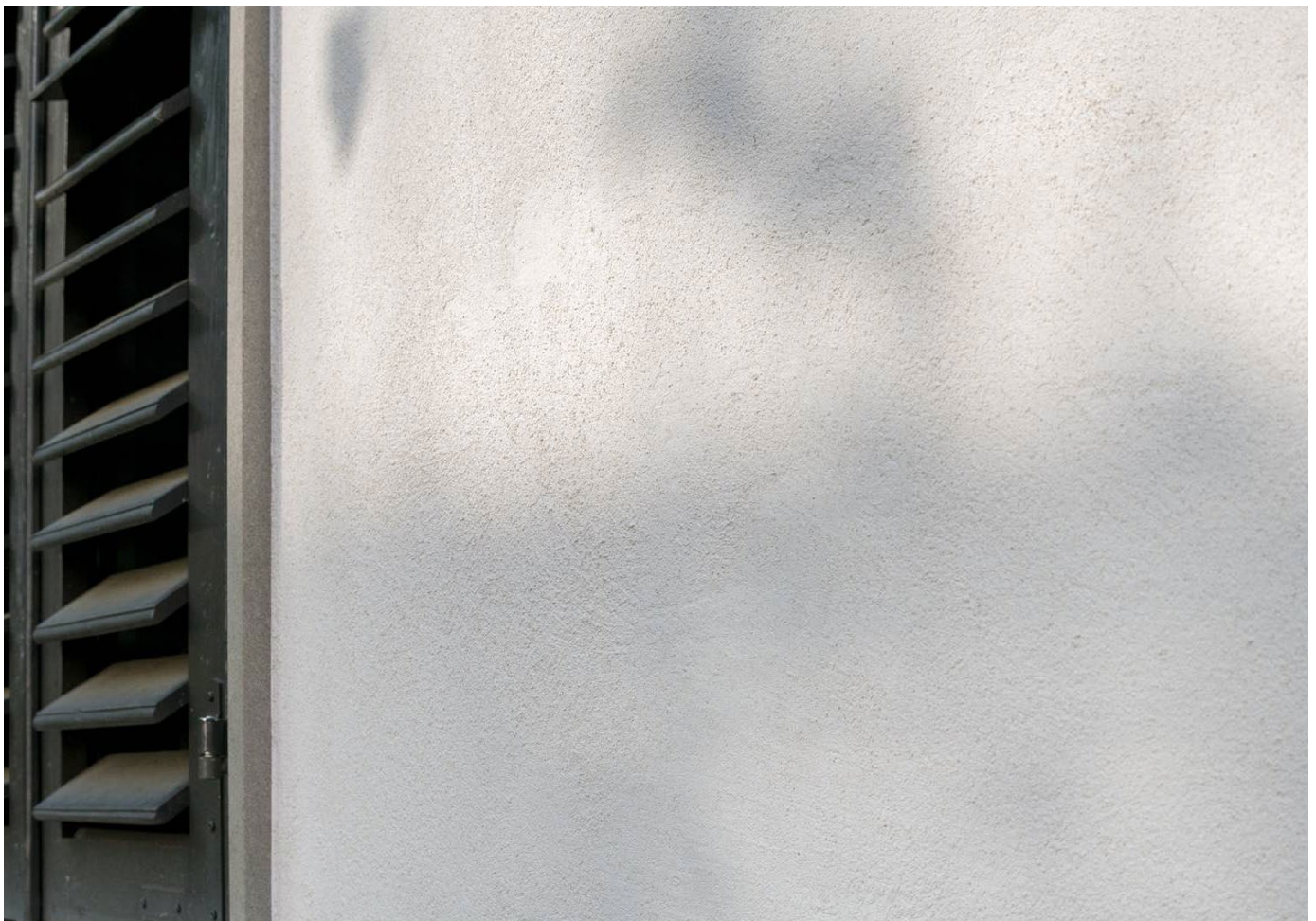
Hönggerstrasse: Deckputzerneruerung mit reinem Kalkputz ohne zusätzlichen Anstrich
