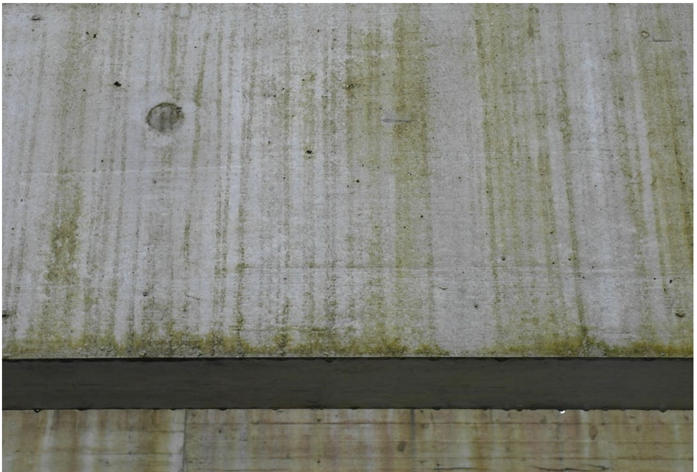
Luegislandstrasse: Regentropfen bleiben an der hydrophoben Betonoberfläche kleben oder kullern an dieser herunter; es bilden sich Schmutzschlieren.
