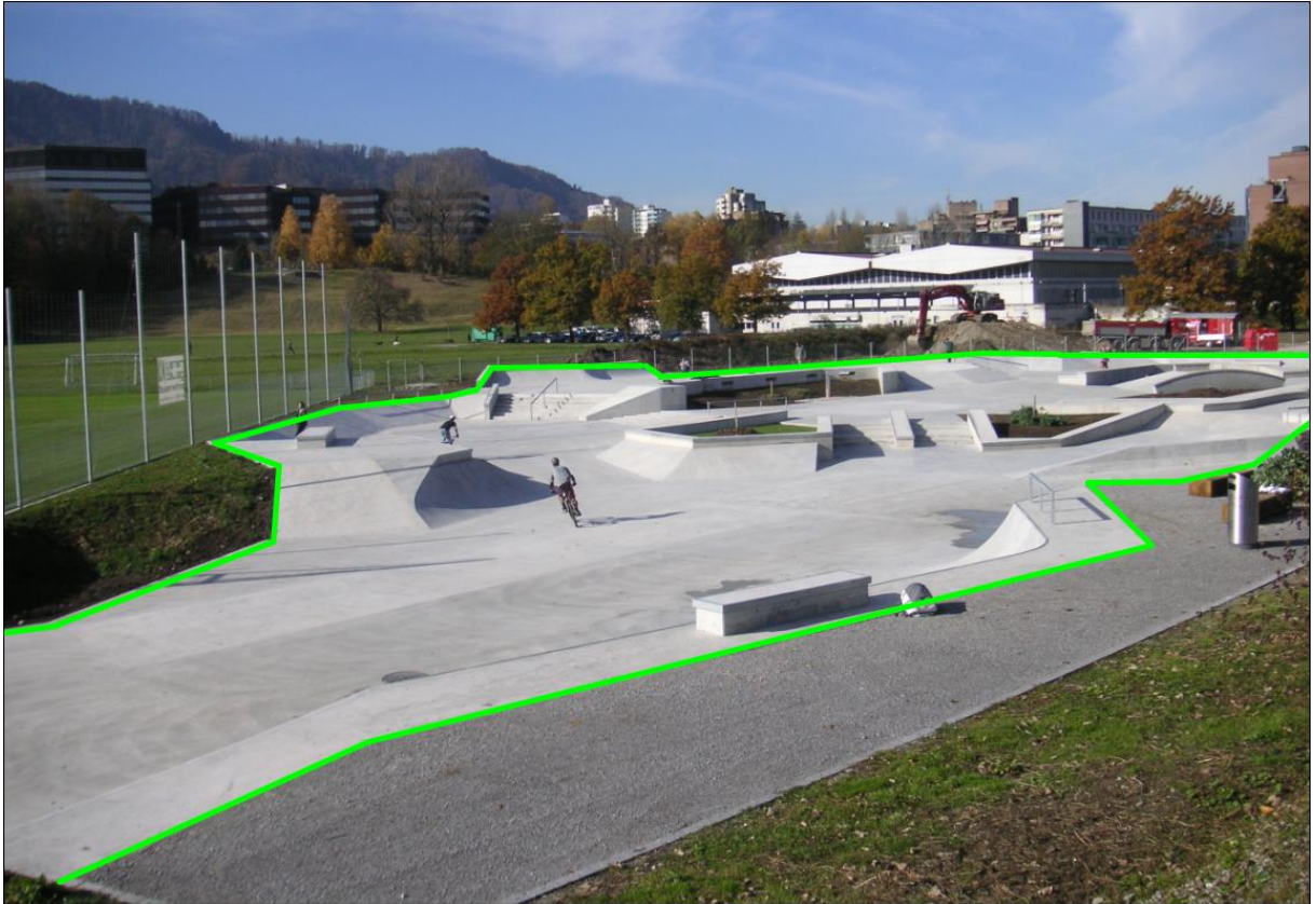
Bild 2 - nördlicher Teil der Anlage
