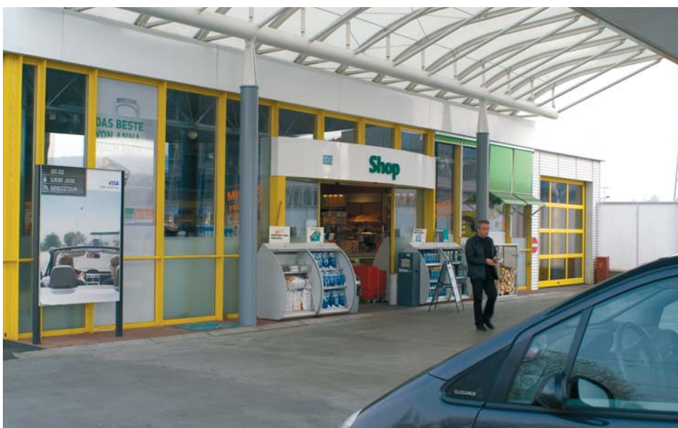
Tankstellenshop Ecke Thurgauerstrasse / Glattparkstrasse
