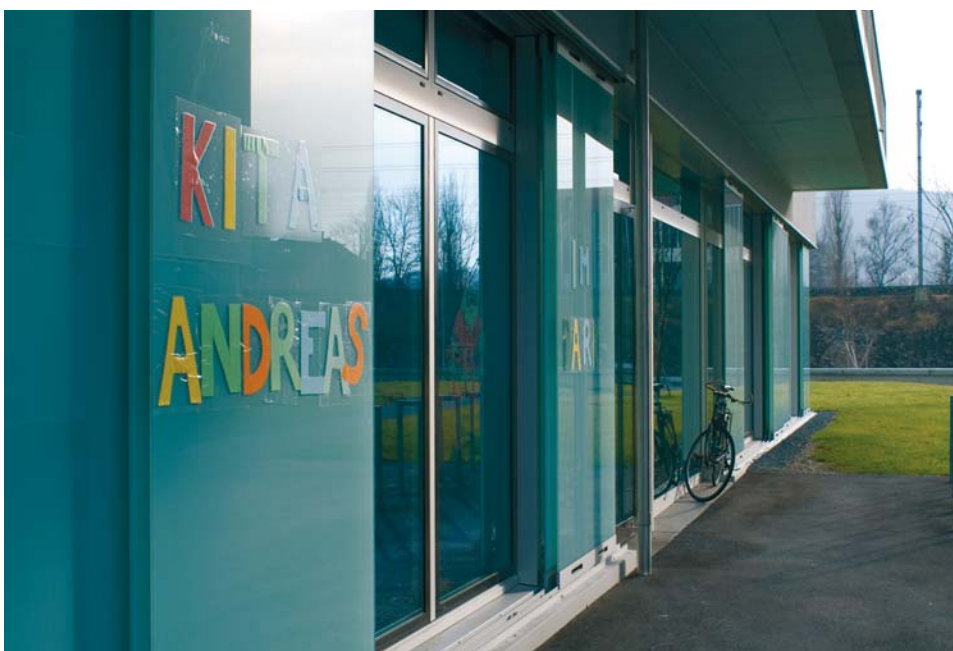
Kindertagesstätte in Wohnüberbauung Andreasark 1
