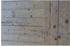
Erhalt, Sanierung Bretterböden
