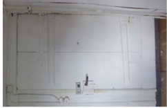
Erhalt, Sanierung Türen
