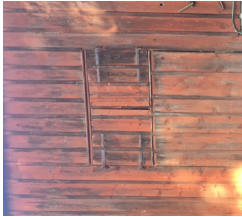
Streichen, Instandsetzung Verschalung
