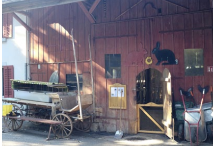
Scheune mit Tenn, Ansicht Nord
