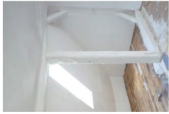
Erhalt Tagwerk Besprechungsraum DG
