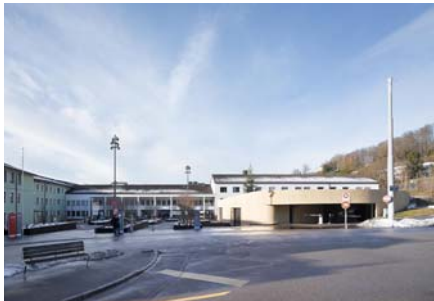
Blick von Tièchestrassè Richtung Garage (rechts) und Haupteingang (links)
