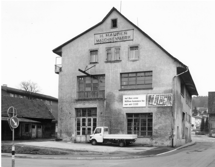
Ansicht von Norden, BAZ, 1991
