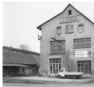
Vorplatz zur Zehntenhausstrasse mit Vordach
