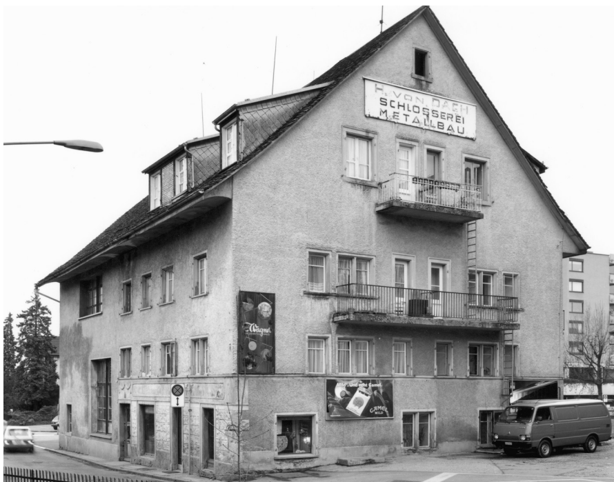
Ansicht von Süden, BAZ, 1991
