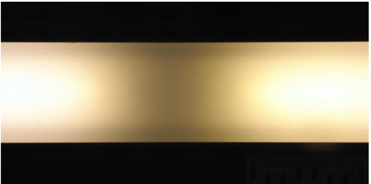
Abbildung 7: Detailansicht FL-Leuchte: mit Randschatten zwischen zwei Leuchten
