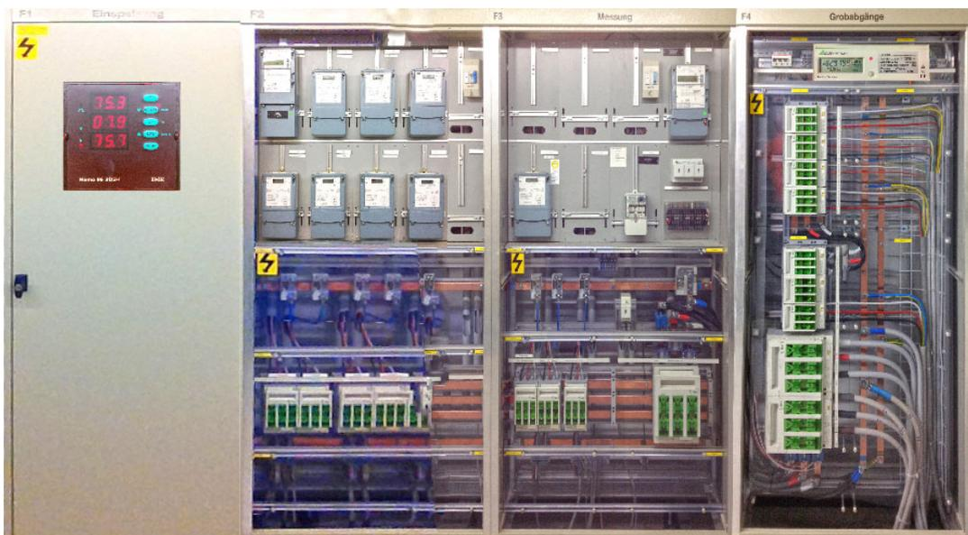
Figur 10: Struktur der Elektroverteilung mit Hauptverteilung und Unterverteilungen
