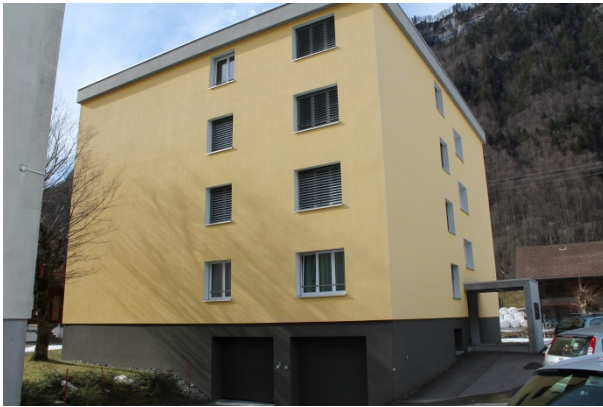
Figur 36 Foto der Ostseite des sanierten MFH in Linthal
