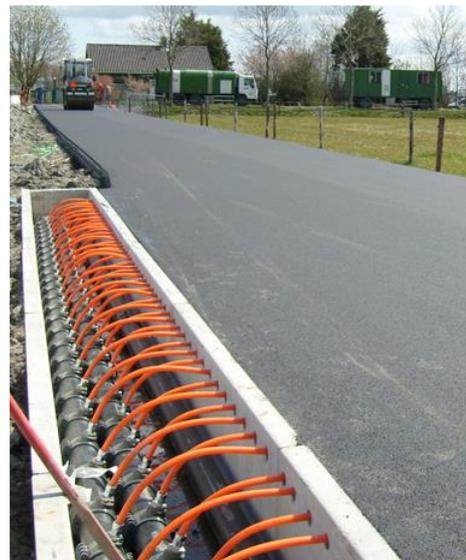
Bild 5.4: Rehau bietet wärmefeste Kunststoffrohre an, die sich zum Eingießen in den heißen Asphalt eignen. Primär wird das Produkt von Rehau aber zur Beheizung von Strassen im Winter und nicht als Kollektor eingesetzt [2].
