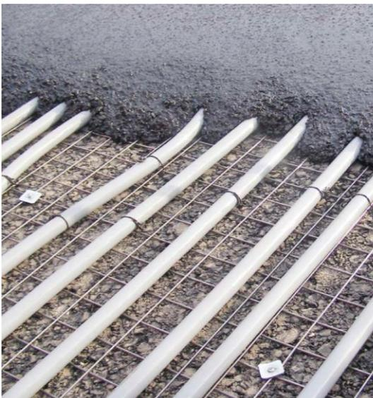
REHAU bietet mit RAUWAY stabil in jeder Hinsicht ein optimales Rohrsystem. Für den Einsatz im Gussasphalt sind drei Aspekte zu beachten: Zunächst muss das Verhältnis von Durchmesser zu Wanddicke dahingehend optimiert werden, dass eine ausreichende Ringsteifigkeit des Rohrsystems erreicht wird. So werden die Rohre beim Einbau nicht deformiert.
