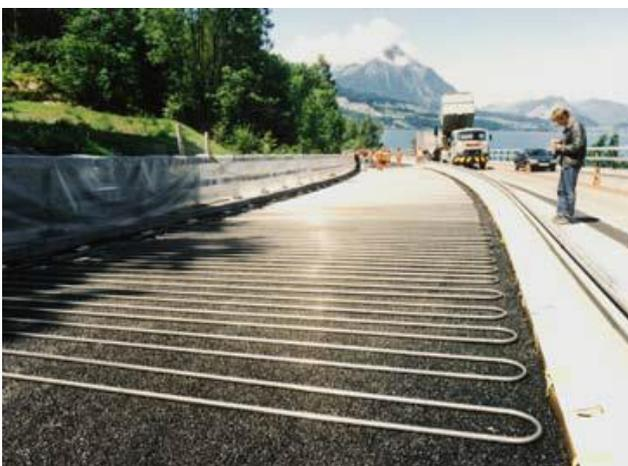
Während OGI und Rehau Kunststoffrohre einsetzen, wurden im 1994 von Polydynamics in der Schweiz realisierten Projekt SERSO Chromstahlrohre verwendet [8]. In diesem Projekt wurden nur 140kWh/m<sup>2</sup> Wärme gesammelt [9]. Weshalb der Ertrag hier soviel tiefer ist als von OGI oder B. Matthey, Bild 5.2, kommuniziert, ist unbekannt. Vermutet werden die höheren Speichertemperaturen von 9 bis 14°C, statt 5 bis 10°C im Falle des Wärmepumpenbetriebs.
