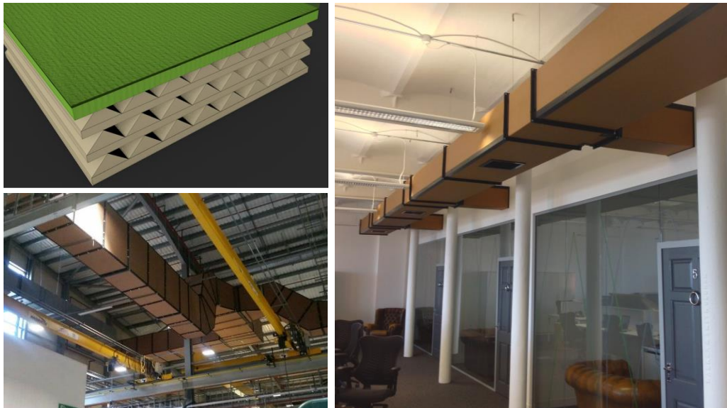
Abbildung 15: Dreischichtiger Aufbau der GatorDuct ® -Produkte (o.l.) und ausgeführte Lüftungsbeispiele [20].
