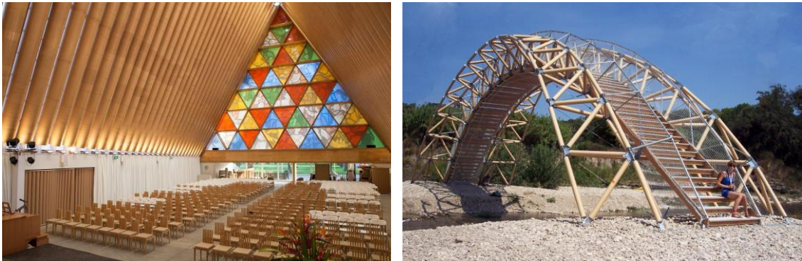
Abbildung 10: Kartonanwendungen im Design- und Architekturbereich (v l n r): Wiggle Side Chair , Frank Gehry, 1972; Cardboard Banquette Pavillon , Cambridge, 2009; Paper House , Shigeru Ban, 1995; Pavillon Hermès , Shigeru Ban, 2011; Christchurch in New Zealand , Shigeru Ban, 2011; Pont du Gard , Shigeru Ban, 2007.
