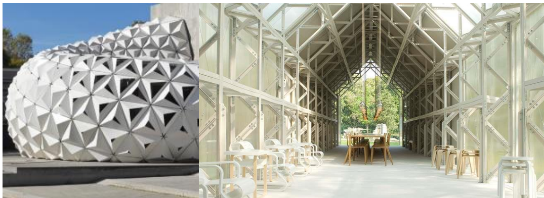
Abbildung 22: (v r n l) Anwendung von Biokunststoffen im Bausektor. Fassaden Mock-Up an der ITKE Universität Stuttgart (System ArboSkin), Artek Pavillon von Shigeru Ban in Mailand von 2007 (gesamtes Gebäude aus UPM ProFi wood plastic) [31].
