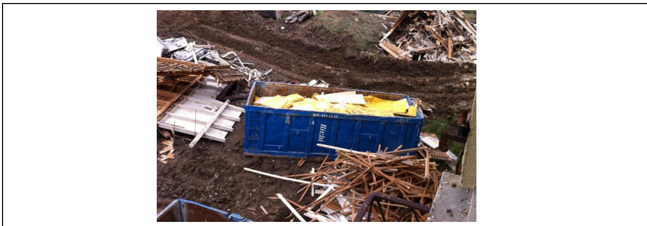
Abbildung 11: Separat gesammelte Glaswolleplatten aus dem Rückbau der Wohnsiedlung Rautistrasse.
