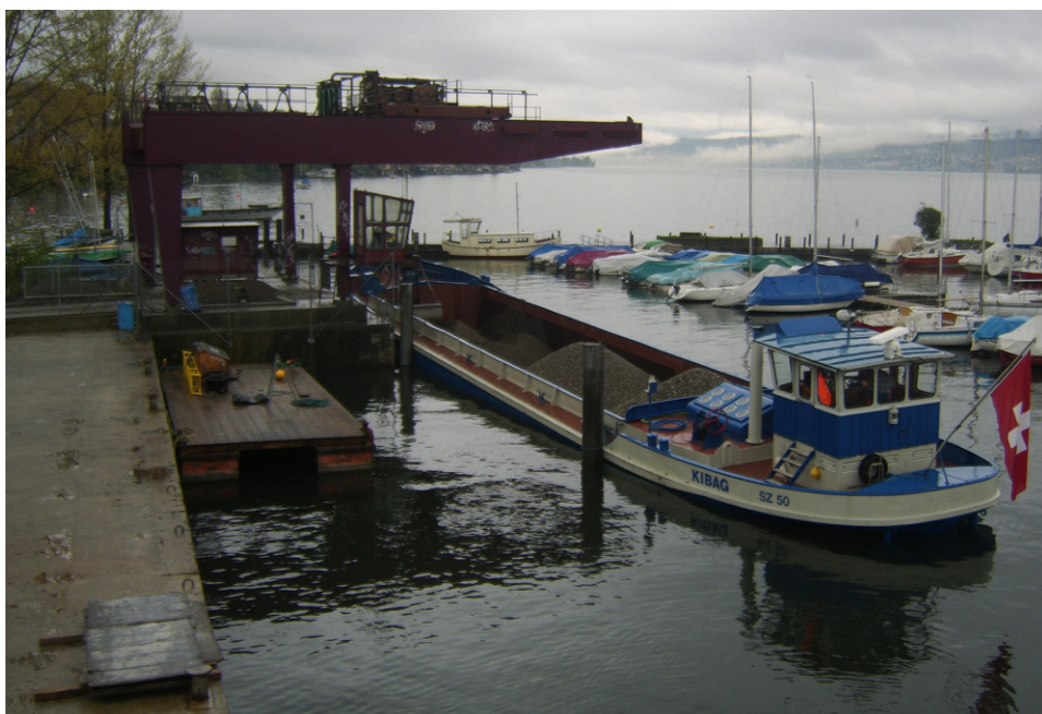
Abb. 10: Verladeanlage der KIBAG
