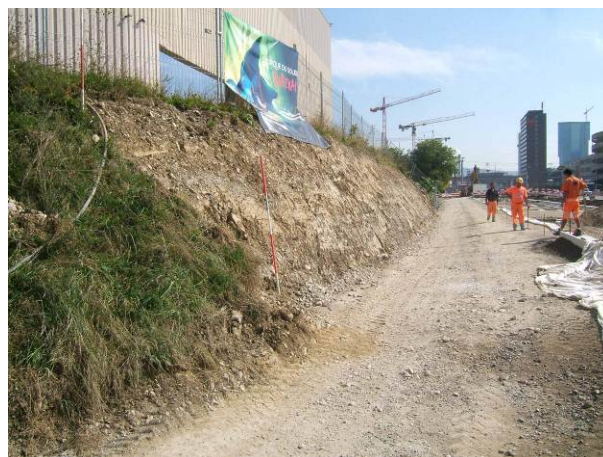
Fig. 8: Ein Teil der Böschung wurde bereits abgetragen.
