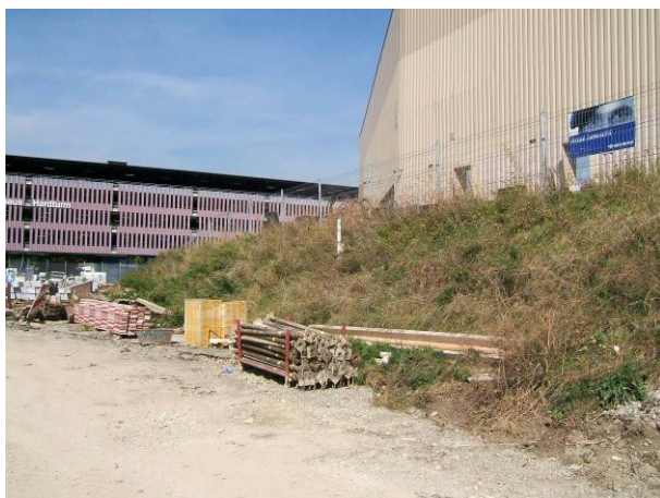
Fig. 7: Die südexponierte Böschung liegt brach.
