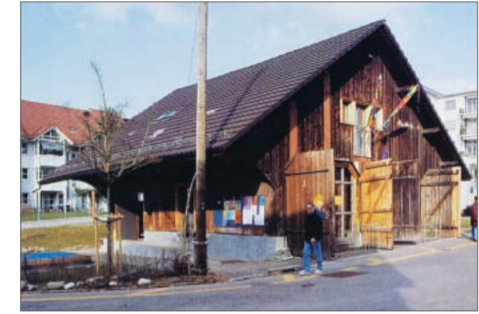
Umnutzung Scheune (Hurdäckerstrasse 6)
