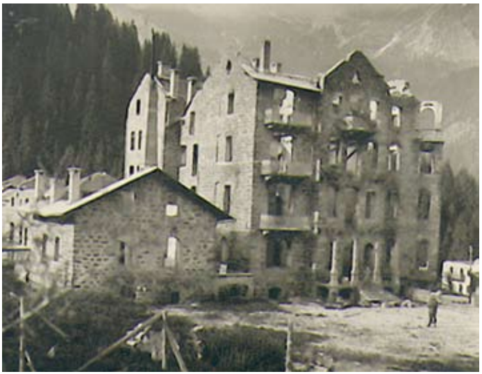
Das ausgebrannte Hotel Fratazza
