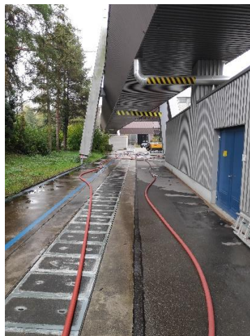
Bild 11: Leitungsbau (Quelle: Holger de Vries)
