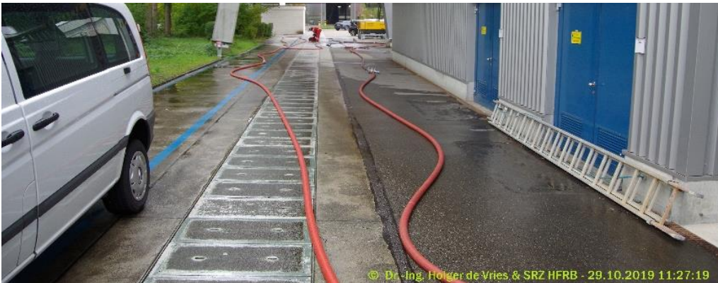
Bild 4: Leitungsbau (Holger de Vries)
