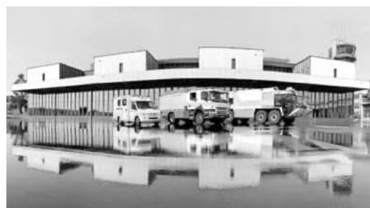
Neues Wachengebäude am Flughafen Zürich. (Bild: SRZ)
