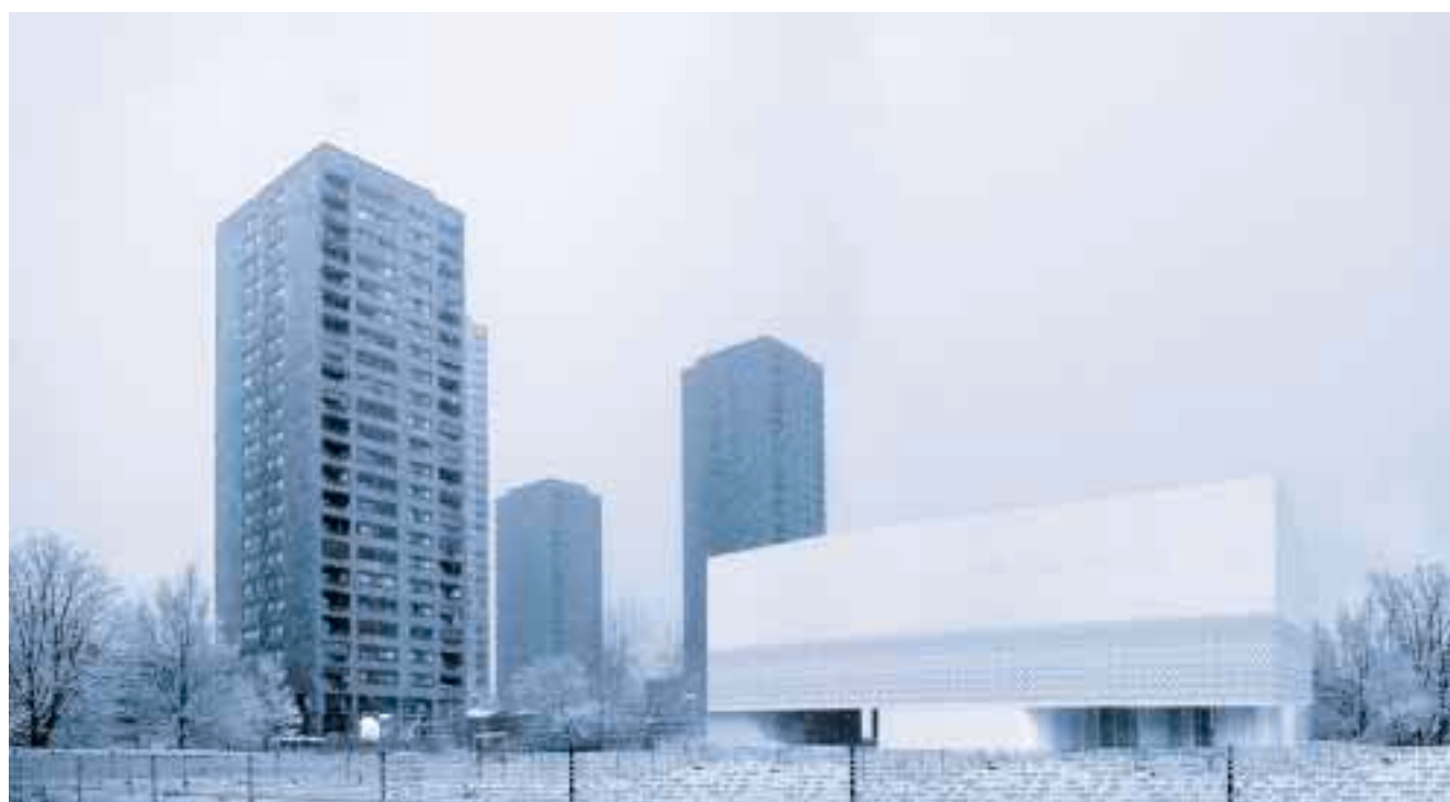
Auf einen teuren Aushub wird verzichtet. Die neue Sporthalle wird so ihre ganze Grösse und ansprechende Architektur zeigen
