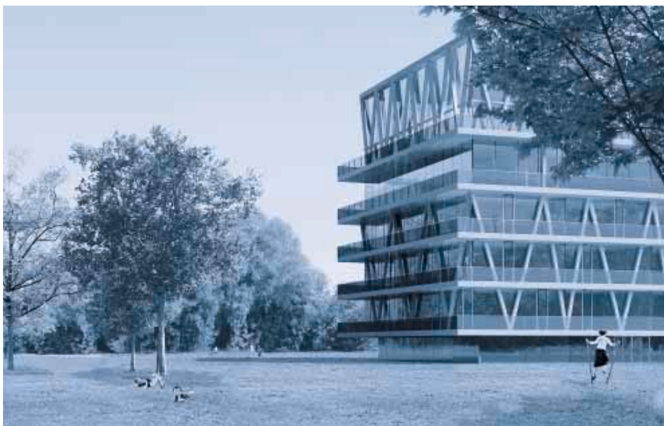
Das Schulhaus braucht wenig Land. Das gibt mehr Grünfläche für alle
