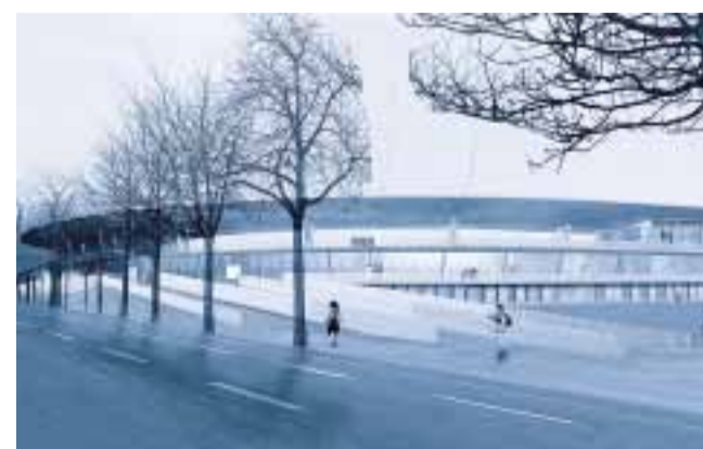
Rampen führen ins Restaurant, das offen ist für die Bevölkerung und den Blick ins Stadion ermöglicht.
