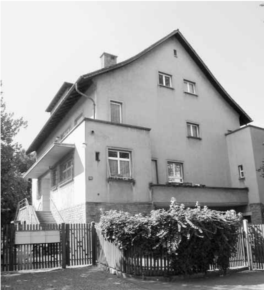
Die «Villa Landolt» ist renovierungsbedürftig und nicht erhaltenswert. Sie soll deshalb durch einen zeitgemässen Neubau von ähnlichen Ausmassen ersetzt werden.
