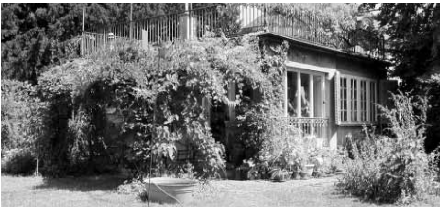
Das denkmalgeschützte Gartenhaus ist ein Überbleibsel des Wohnhauses «Geissberg» (18. Jahrhundert) und soll um einen Stock erhöht werden.
