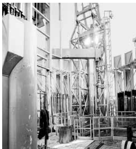
Teil der Bohreinrichtung.
