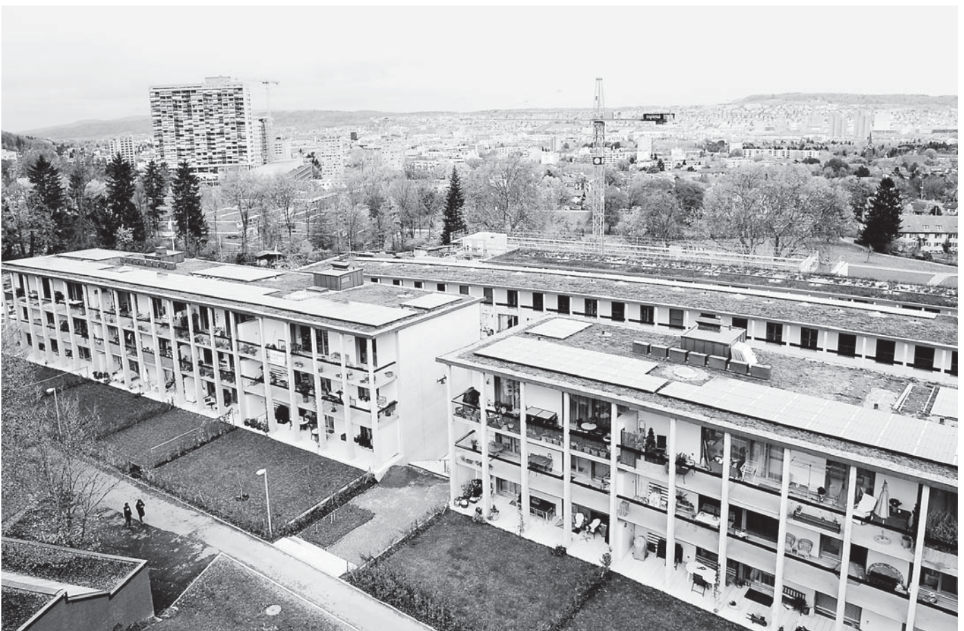
Die Familienheim-Genossenschaft Zürich (FGZ) nutzt das Solarpotenzial: In ihrer Überbauung Grünmatt entsteht derzeit die grösste Solarstromanlage der Stadt, noch grösser als jene des Letzigrund-Stadions. Die Dächer sind zusätzlich ökologisch wertvoll begrünt.
