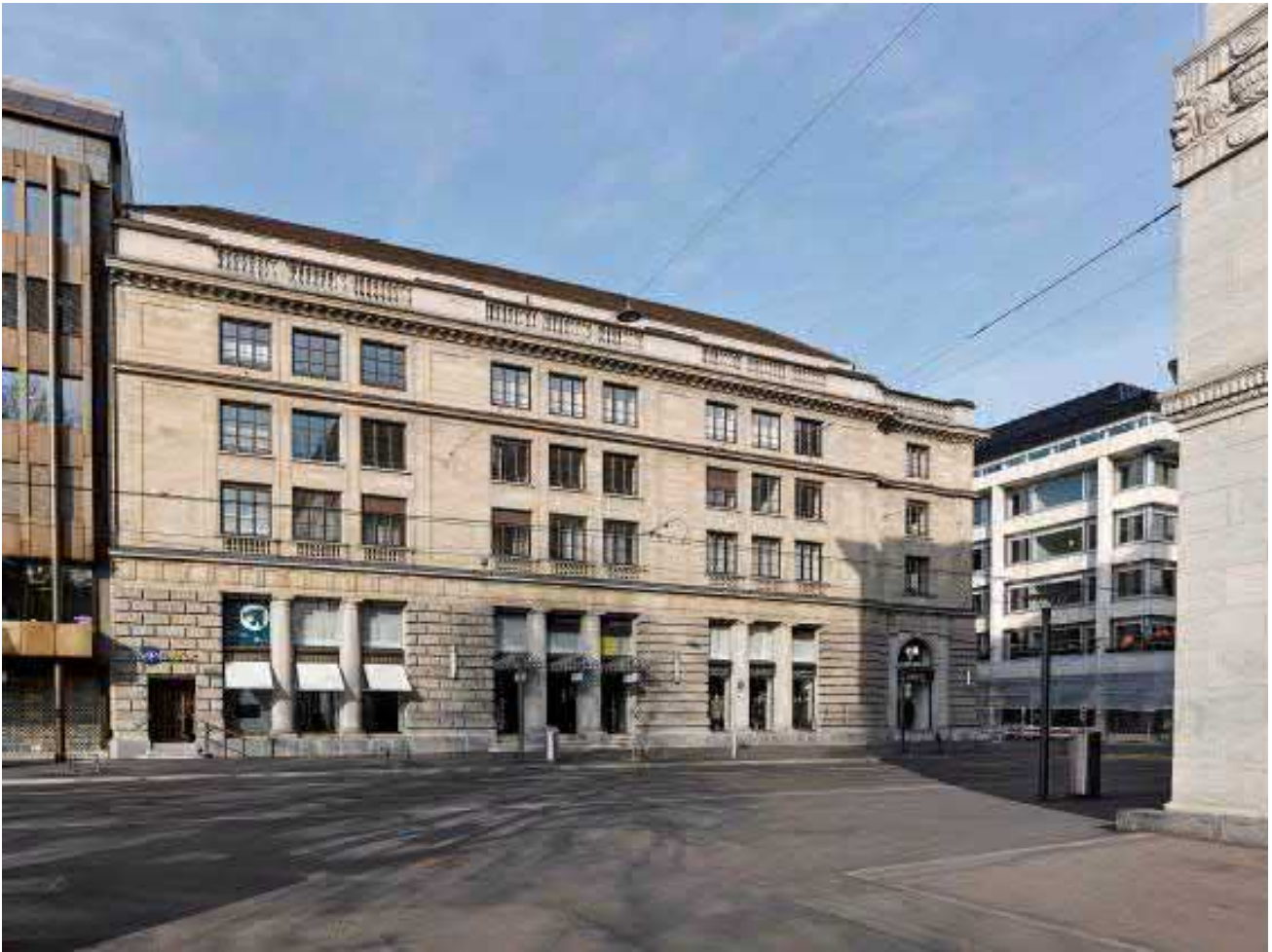
Abbildung 3 Bestehendes Gebäude Seite Bahnhofstrasse
